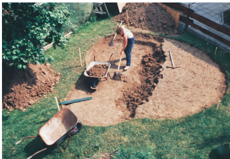
Hloubení jámy pro budoucí rybníček
