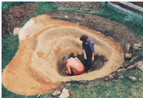
Vyhlazení podkladu jemným písek
